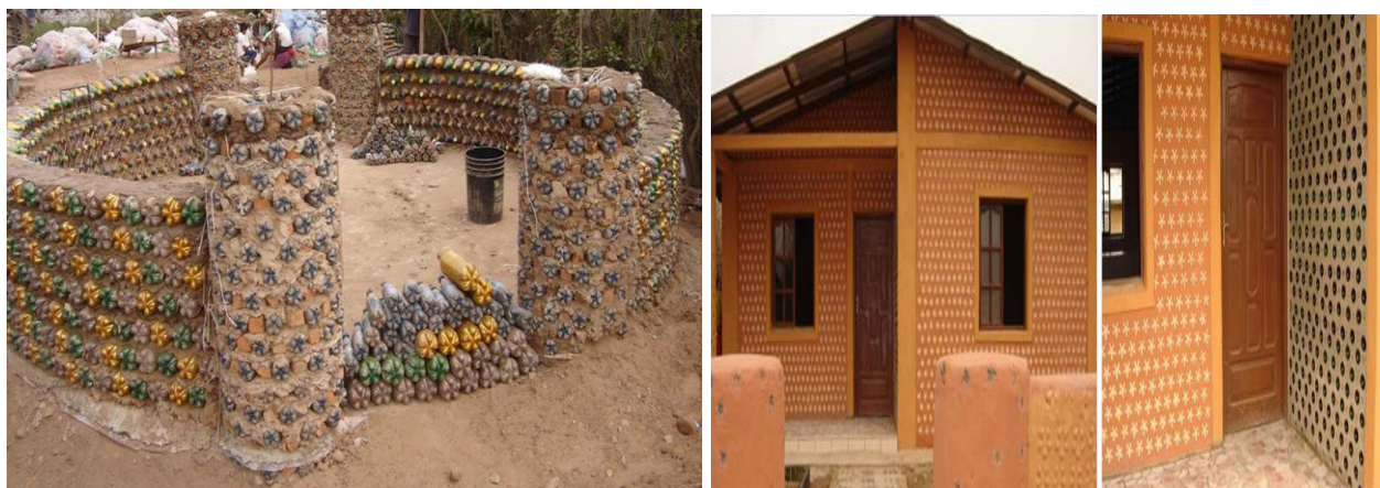
Figura 16. Obras en proceso y terminadas con ecoladrillos.
